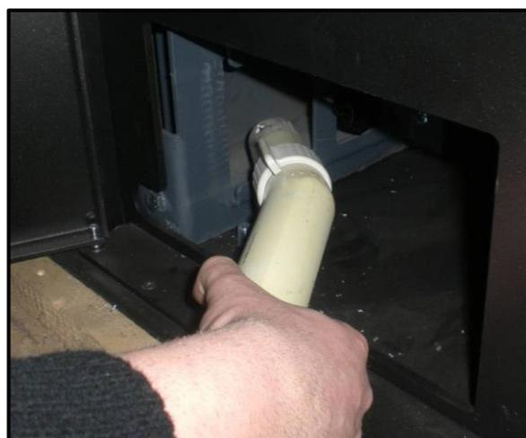
Ouvrir le volet sous le côté pellet et après avoir dévissé le volant, retirer la plaquette du parcours des fumées latéral. Aspirer le dépôt à l'intérieur en utilisant un aspirateur approprié, puis refermer le conduit en s'assurant d'avoir bien fixé la plaquette.
